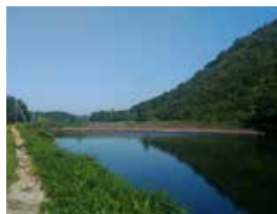
毎年5月下旬は集落全体で溝掃除。堤体の草刈も実施
