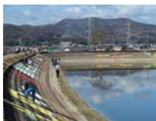
堤体のブロック絵画の塗り替えをおこないました
