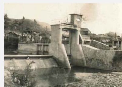
写真 取壊し前の山田川頭首工
