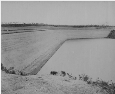
写真 宮ヶ谷調整池堤体
