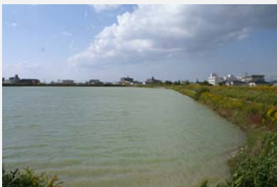
写真 岩岡支線 17号ため池
