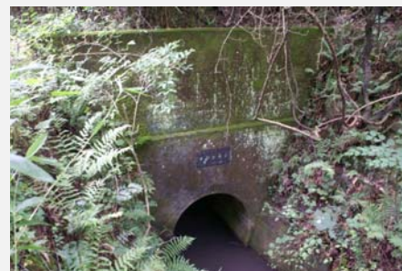
写真 芥子山隧道
