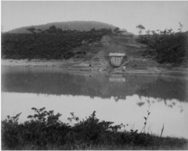
写真 淡河川疏水二十五番 (宮ヶ谷)隧道鉄管入り口
