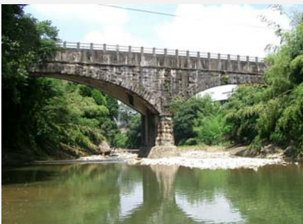
写真 御坂サイフォン水路橋
